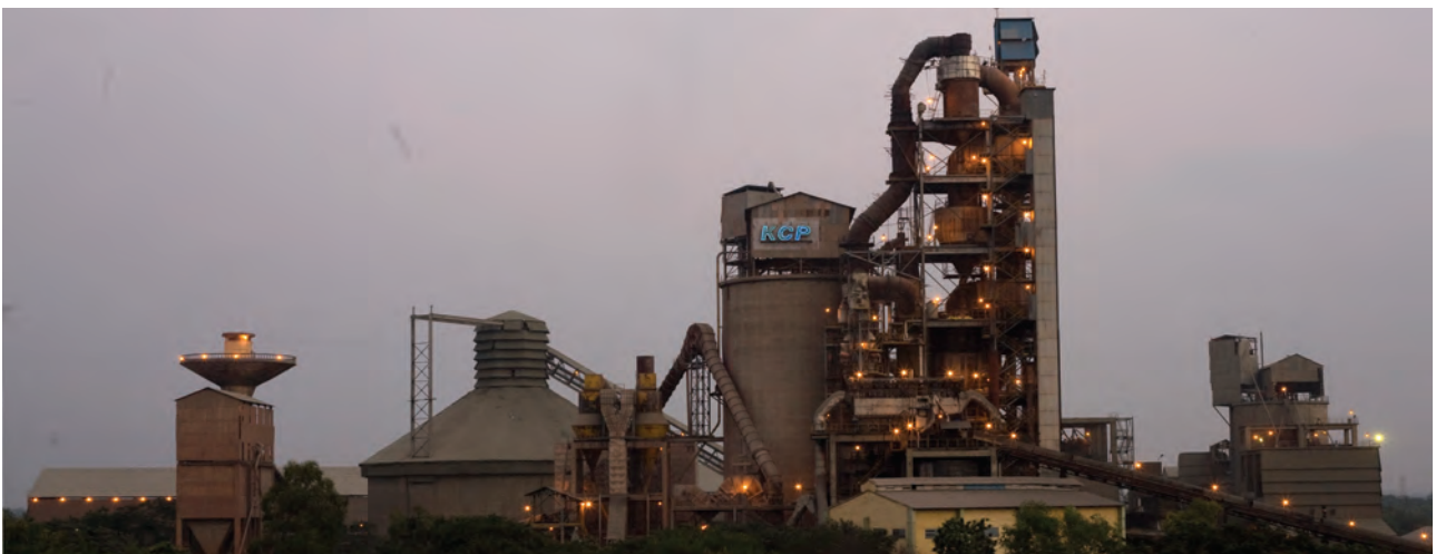
Cement Production Unit - I, Macherla
